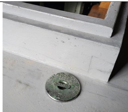
Figur 2 Tømningsventil findes ved nedgang til maskine
